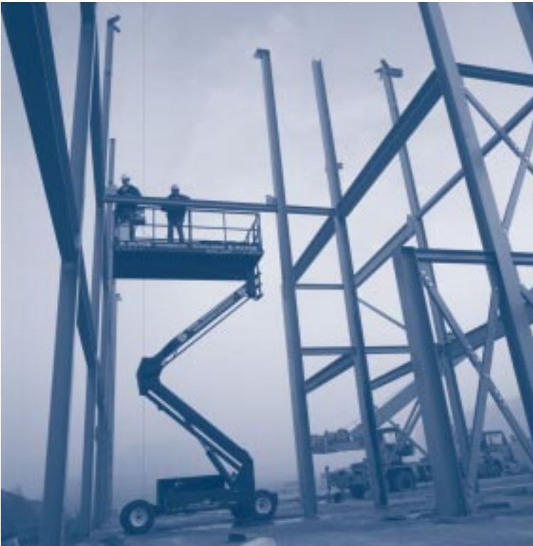
Montagewerkzaamheden vanuit een hoogwerker
