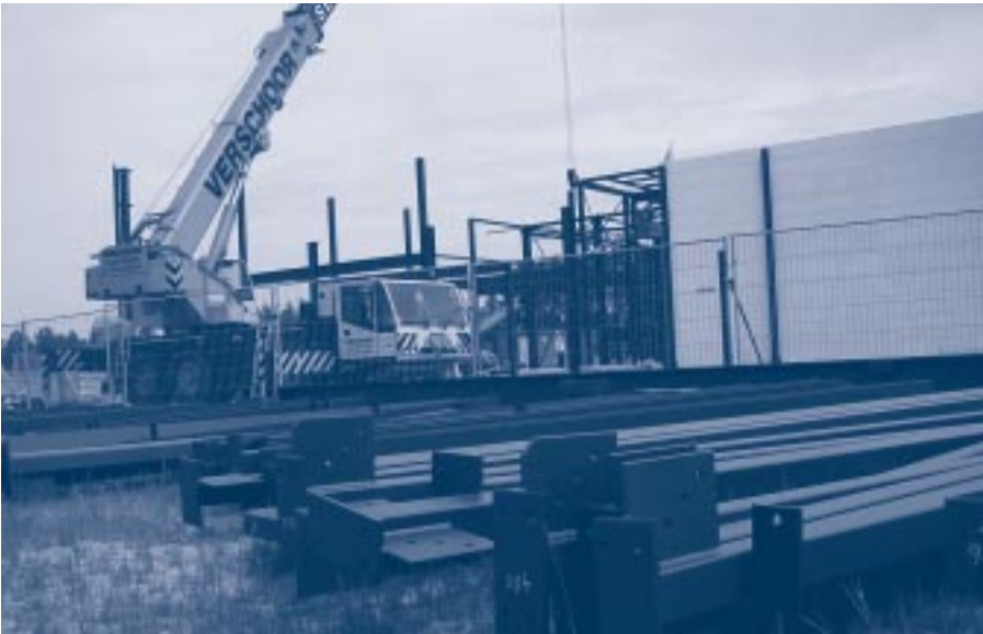
Opslag van constructiedelen
