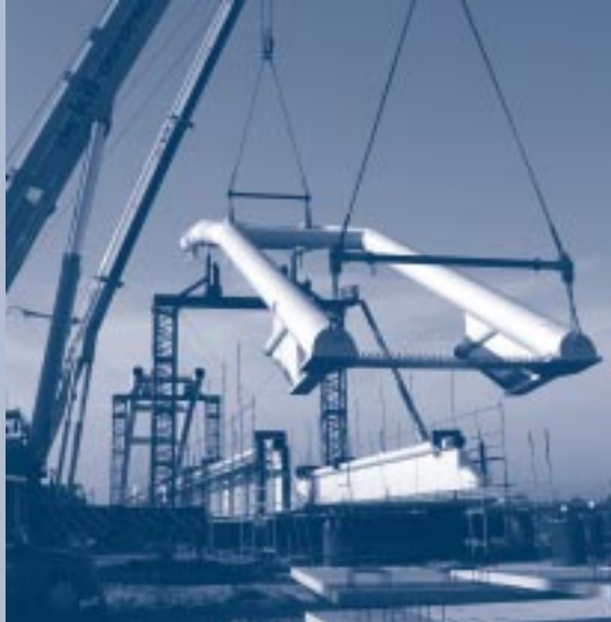
Hijsen met meerdere kranen
