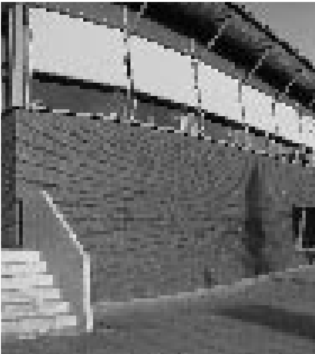
Een gelijmde gevel
