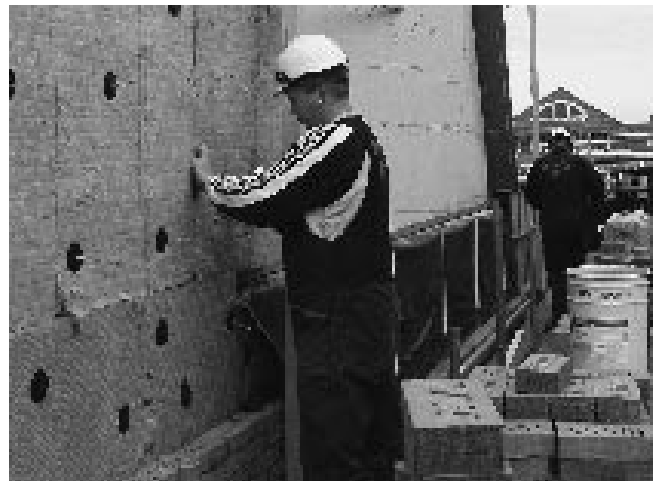
Het aanbrengen van isolatiemateriaal
