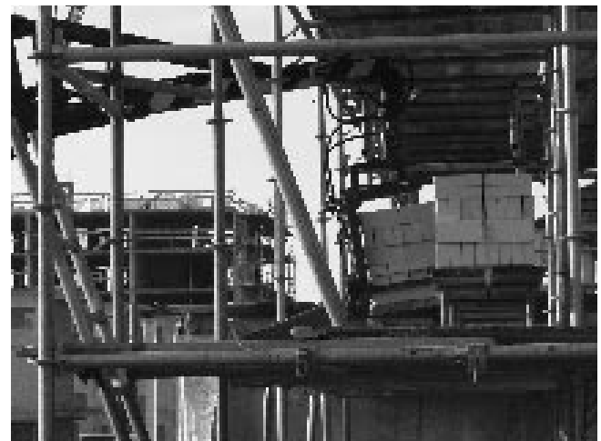
Speciale jip op de verreiker om tussen de steigervloeren te kunnen opperen met een kleine stenenklem
