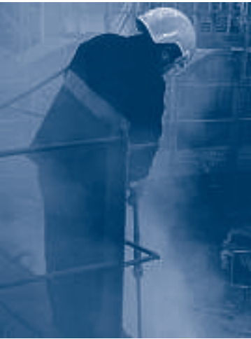
Aangedreven kap, waarbij ventilator en filter in de kap zijn geïntegreerd
