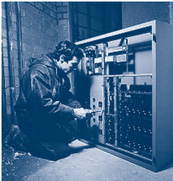
De aanleg van een elektrische installatie.
