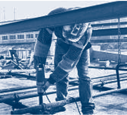
Elektrisch handgereedschap moet dubbel geïsoleerd zijn.
