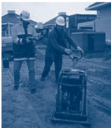
Bij het gebruik van een trilplaat is gehoorbescherming vereist.
