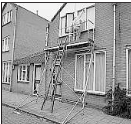
De ondersteuningsconstructie is lichter en veiliger dan de traditionele laddersteiger.
